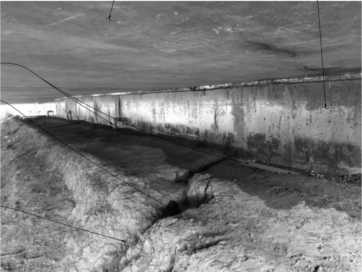
EXISTING ABUTMENT RUTTING N.T.S
