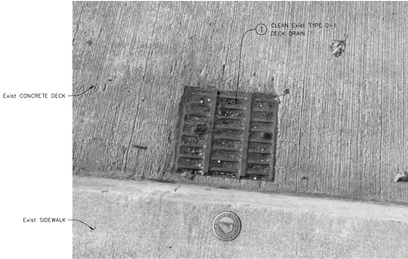
EXISTING DECK DRAIN N.T.S
